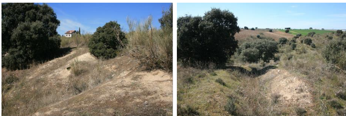
Figura 104. Fotografías de las Trincheras de La Calera en la actualidad. Fuente: IGN.
