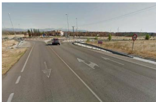
Figura 283. M-600 en el acceso sur
