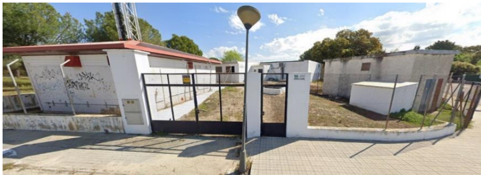
Figura 244. Depósito 2 de la Urbanización La Raya del Palancar. Fuente: Google maps.
