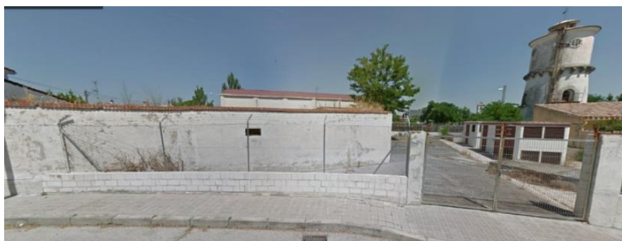
Figura 240. Depósito y torre de elevación de Villanueva de la Cañada. Fuente: Google maps.
