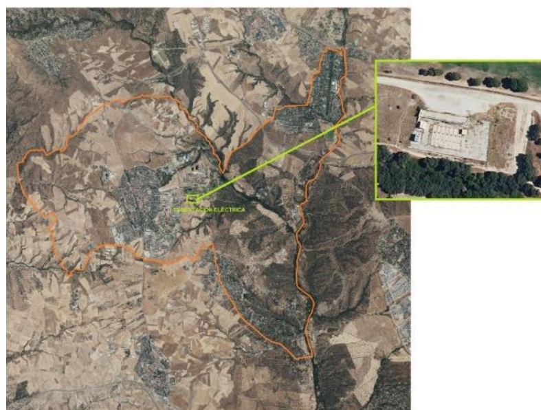
Figura 265. Ubicación de la subestación eléctrica de Villanueva de la Cañada. Fuente: Elaboración propia.
