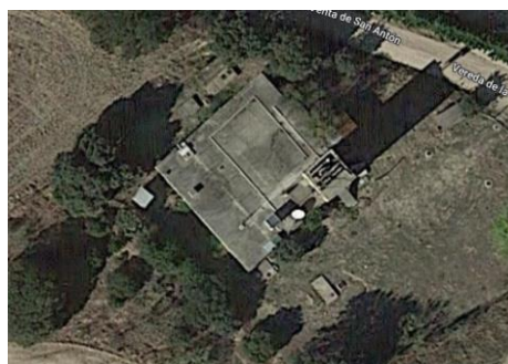
Figura 242. Depósito de Villafranca del Castillo – La Mocha Chica con acceso desde la Vereda de San Antón. Fuente: Google maps.
