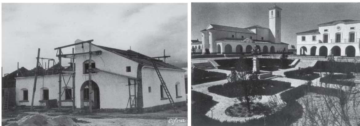
Figura 134. A la izquierda la construcción de la primera manzana de viviendas, Archivo General de la Administración. Y a la derecha fotografía de la Plaza Mayor en 1953 donde se puede ver la iglesia y el ayuntamiento. Fuente: Archivo General de la Administración.
