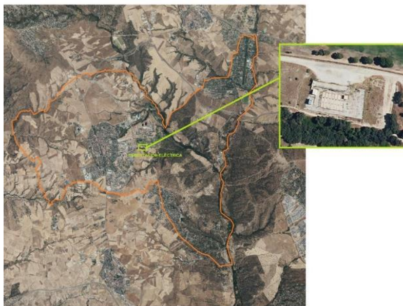
Figura 269. Ubicación de la subestación eléctrica de Villanueva de la Cañada. Fuente: Elaboración propia.
