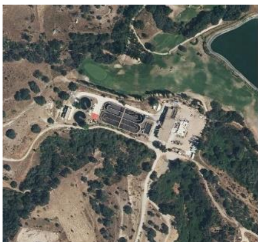
EDAR VILLANUEVA DE LA CAÑADA
