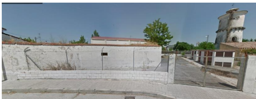
Figura 244. Depósito y torre de elevación de Villanueva de la Cañada. Fuente: Google maps.
