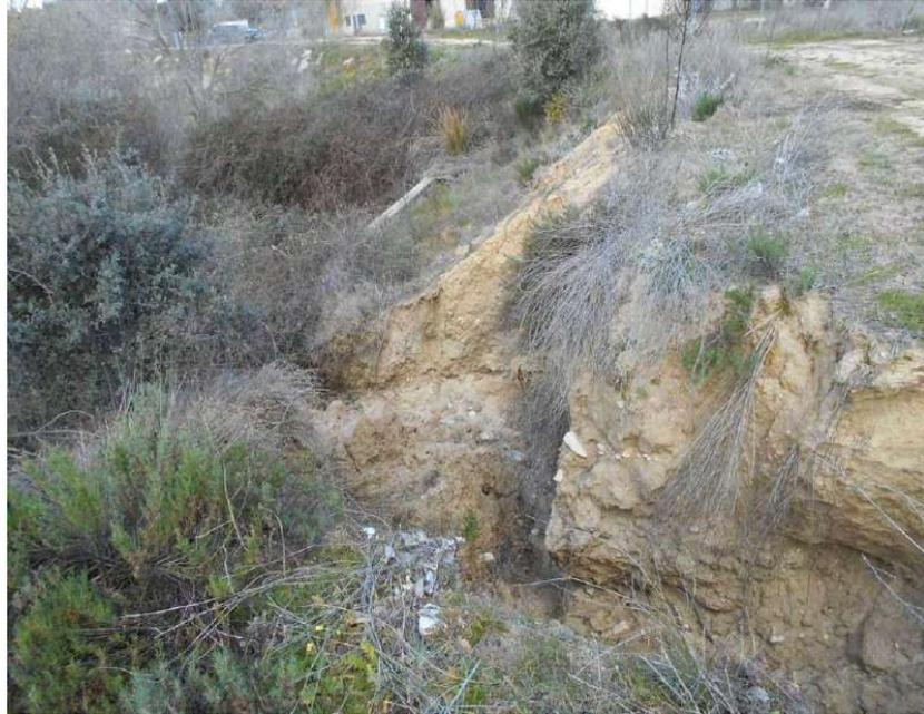
Detalle del desprendimiento del camino con dos tuberías al aire libre
