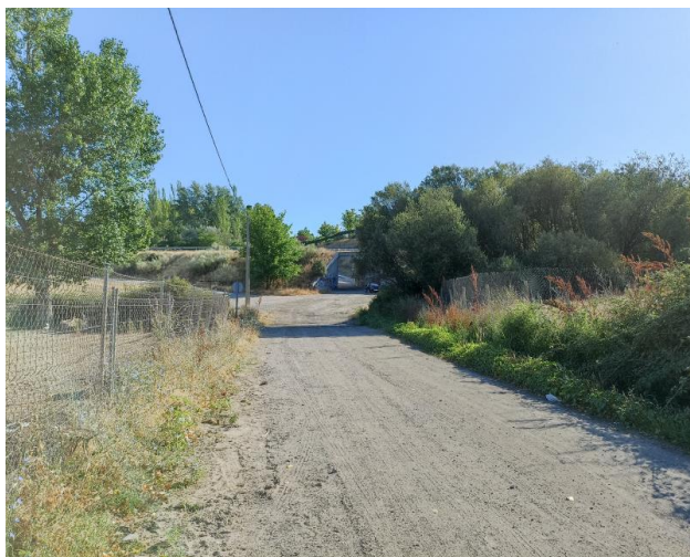
Camino de tierra sin asfaltar siguiendo el trazado del vial 1-14. Al fondo el paso inferior bajo la M-600.
