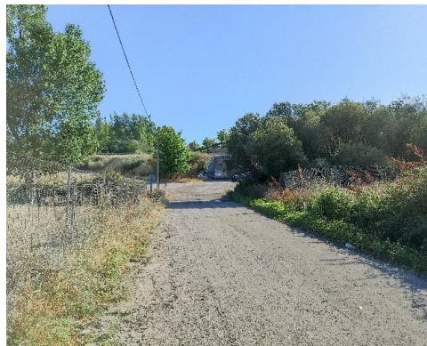
Conexión del vial V 1 14 con la M-600.
