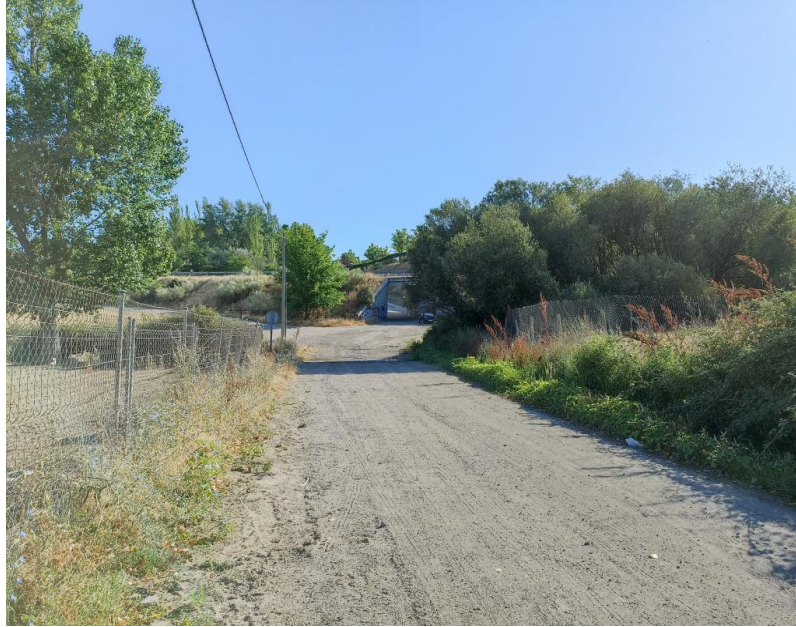
Camino de tierra sin asfaltar siguiendo el trazado del vial 1-14. Al fondo el paso inferior bajo la M-600.
