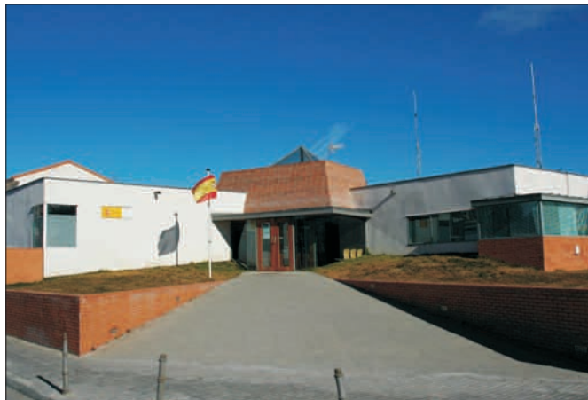
El Ayuntamiento ha propuesto a la Comunidad incluir en el PRISMA las obras de ampliación del Cuartel de la Guardia Civil.
