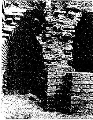
figura 11 PALACIO DE MARI, MESOPOTAMIA S XXI a.C. Construcción de bóvedas de ladrillo por hiladas avanzadas
