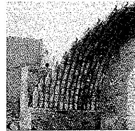
figura 14 CARTAGO, Túnez Kobbat Bent el Rey s III d.C. Bóveda romana de cañón formada por ánforas huecas empalmadas, primera intuición de la bóveda tabicada.
