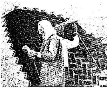
figura 15 construcción tabicada actual en Túnez
