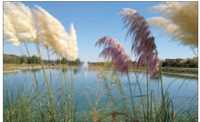
Imagen de la balsa construida especialmente para permitir la puesta en marcha del nuevo sistema de riego.
