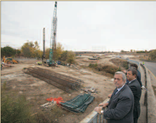
El consejero, Antonio Beteta, junto al alcalde, Luis Partida, visitando los trabajos de construcción de la M-509.
