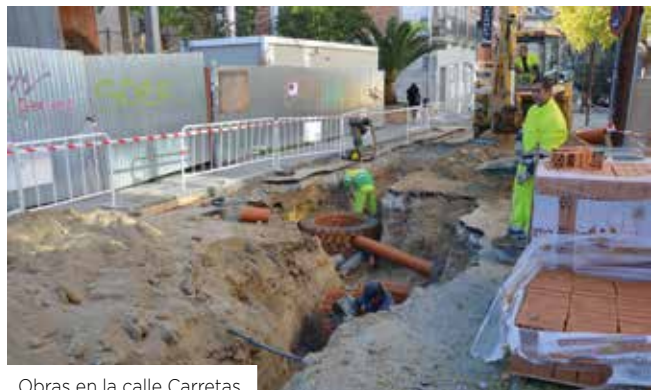
Obras en la calle Carretas.
