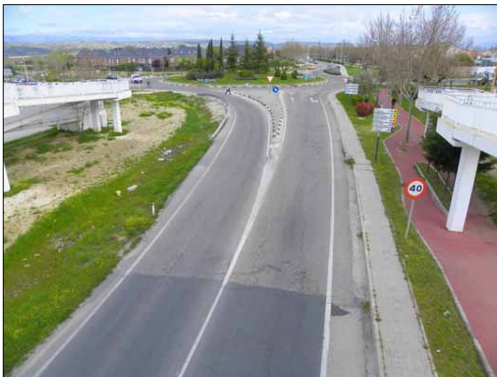
Punto de aforo T, situado en la M-600 (Pardillo Escolar).
