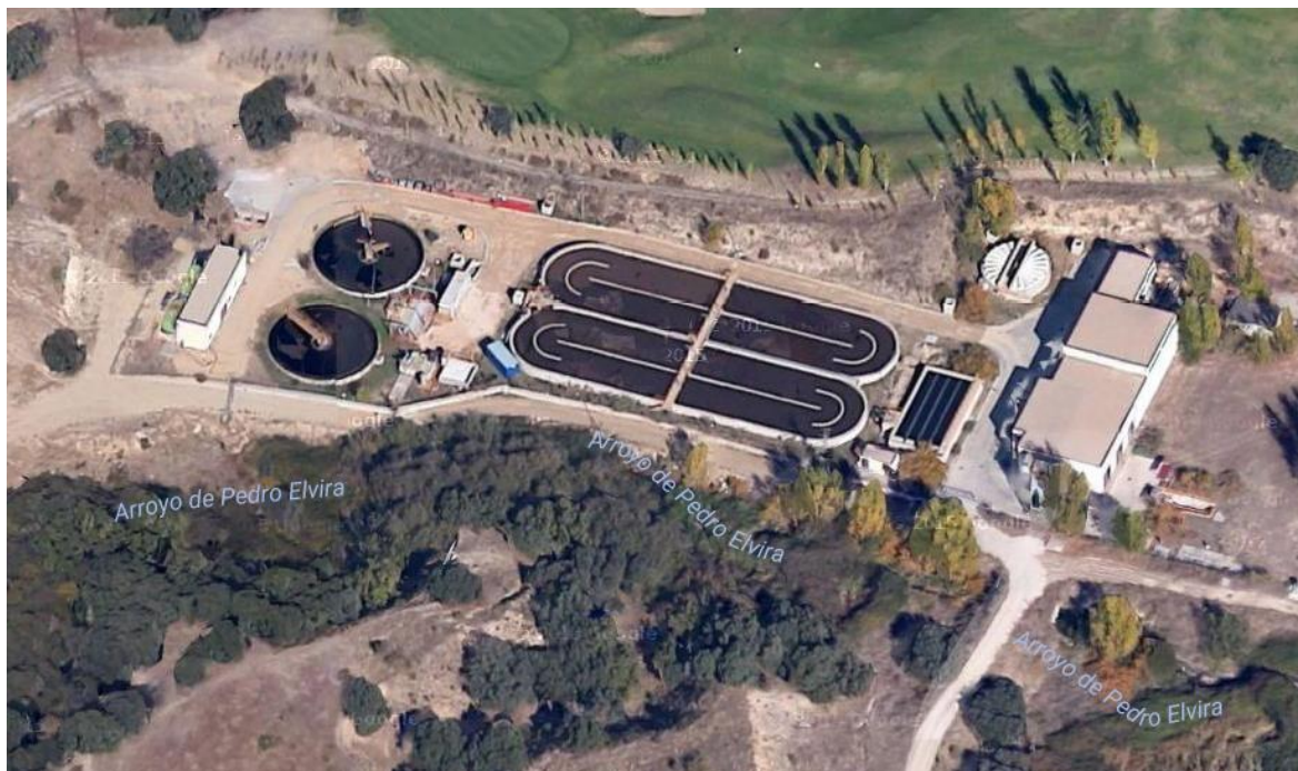
Figura 36. Estación depuradora de aguas residuales, al oeste de la avenida de España.
