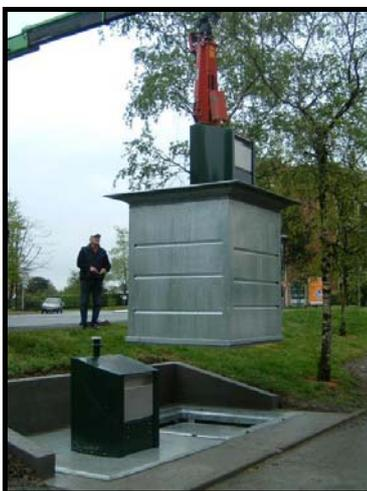
Los residuos son descargados por la parte inferior mediante el sistema de apertura de doble gancho.
