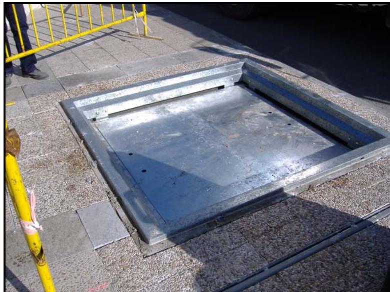
Además, su forma trapezoidal sirve totalmente para el centrado de los equipos en la colocación.
