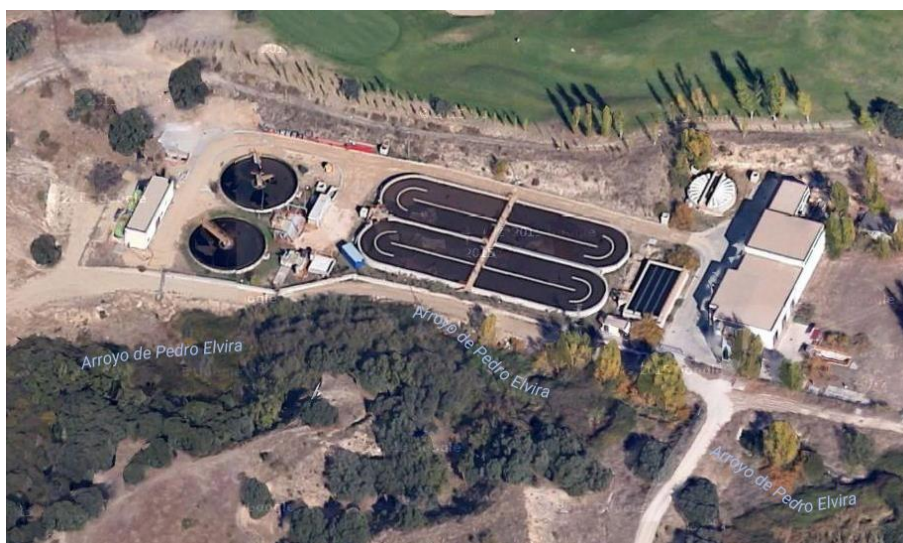
Figura 13. Estación depuradora de aguas residuales, al oeste de la avenida de España.
